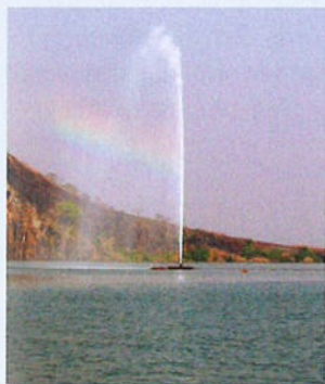
3.56 De ontgassing van het Nyos-meer. Bij het ontgassen ontstaan 20 m hoge fontein.
